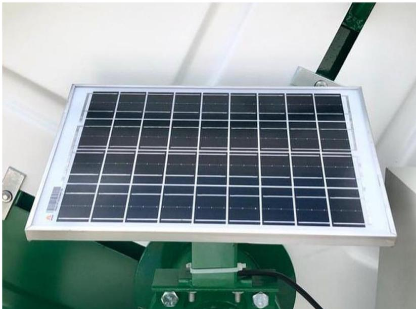
O Hidroturbo possui um painel solar que realiza a recarga da bateria, o mesmo é utilizado para fornecer energia ao painel de comando IP-1200.
